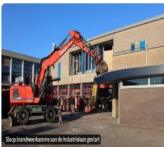
Sloop brandweerkazerne aan de Industrielaan gestart
